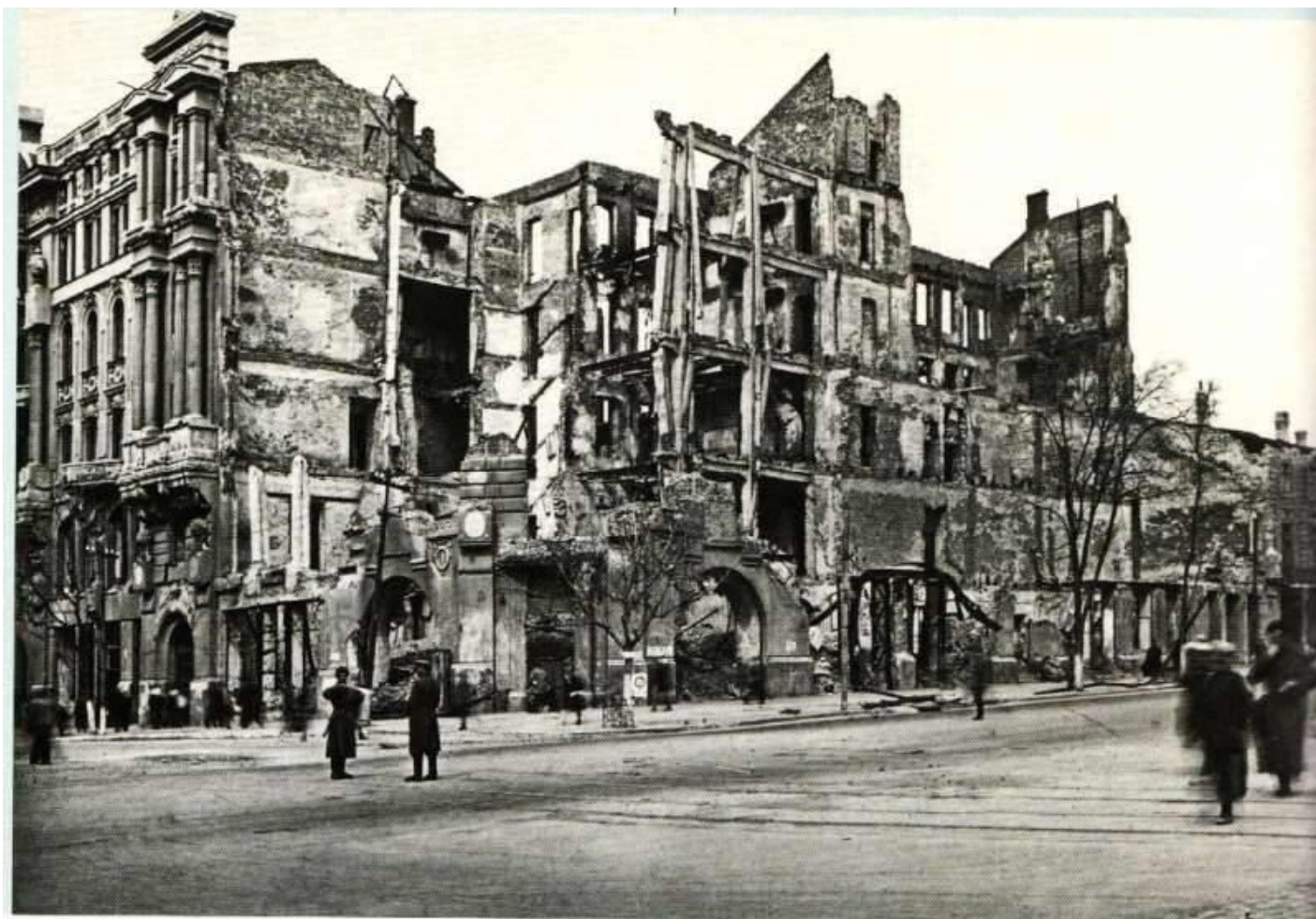
Разрушенное здание по ул. Энгельса, 79 (Б. Садовая). 1941 г. Фото из архива А. С. Хатламаджияна
